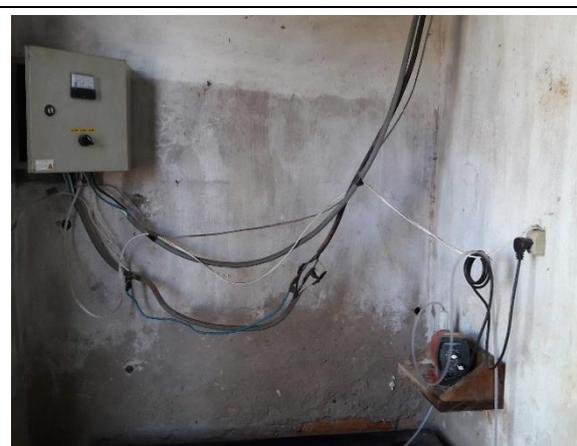
**Imagem 02** – sistema de dosagem com hipoclorito de sódio automático, reservatório de água, e quadro de comando da bomba utilizado no poço **PT05**.
