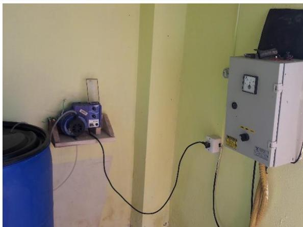
**Imagem 02** – sistema de dosagem com hipoclorito de sódio automático, reservatório de água, e quadro de comando da bomba utilizado no poço PT01.
