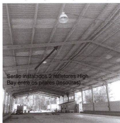
Figura 10 – Especificações instalação refletor High Bay 50W
