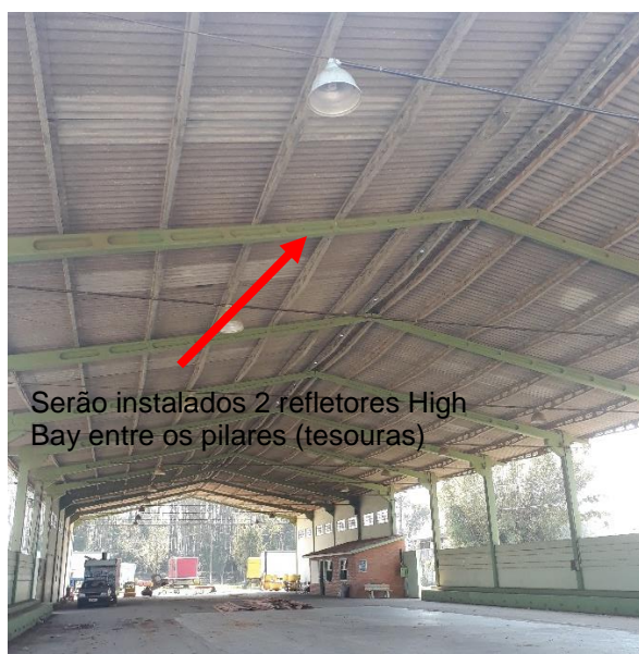
Figura 10 – Especificações instalação refletor High Bay 50W
