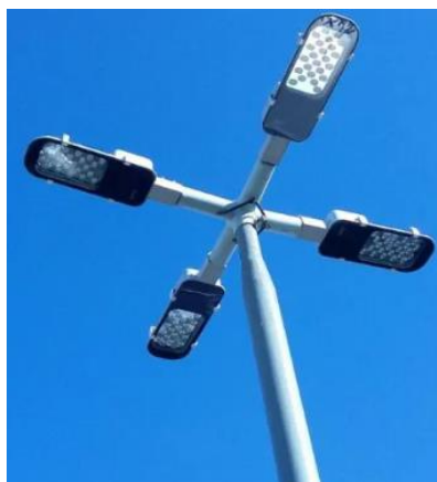
(b) Luminária pública LED 100W em suporte tipo pétala instalada em poste galvanizado
