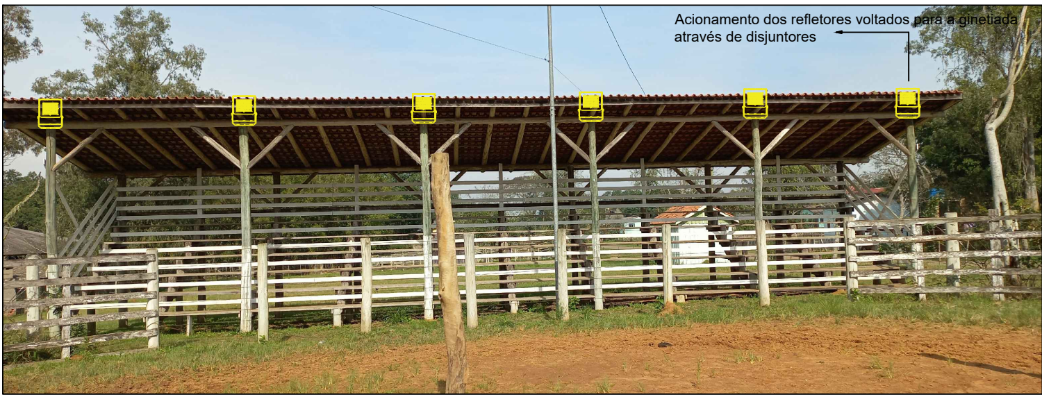
Detalhe 2: Instalar 5 Refletores 150W a cada 2 pilares do pavilhão, voltados ao campo aberto ao lado do mesmo.
