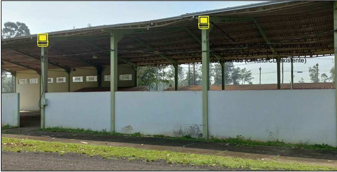
Detalhe 2: Instalar 5 Refletores 150W a cada 2 pilares do pavilhão, voltados ao campo aberto ao lado do mesmo.
