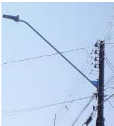
(a) Luminária pública LED 150W em braço longo curvo com sapata instalada em poste de concreto circular
