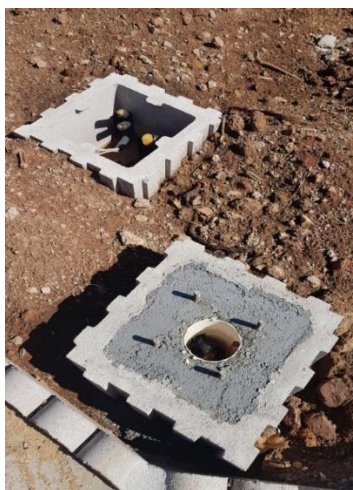
Exemplo de detalhe da sapata com haste terra embutida.
